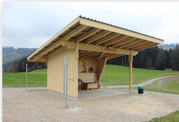
Abbildung 12: Unser Unterstand in der Bauphase
